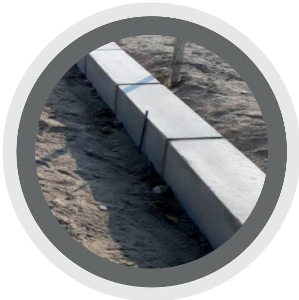
El rayado de las juntas es opcional según la estética y la exigencia del proyecto, se debe realizar a partir de los 30 minutos desde la colocación de los bordillos. El rayado puede ser en forma de V, de U o continuando el nivel de la cara superior.
